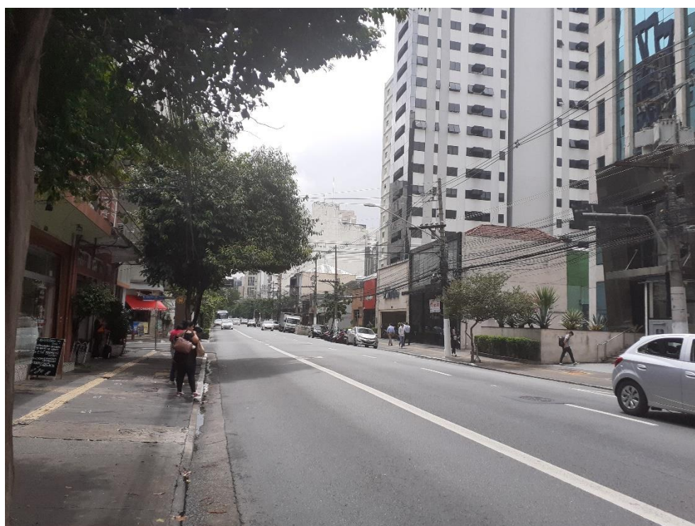
Vista da Rua Joaquim Floriano com imóvel a direita
