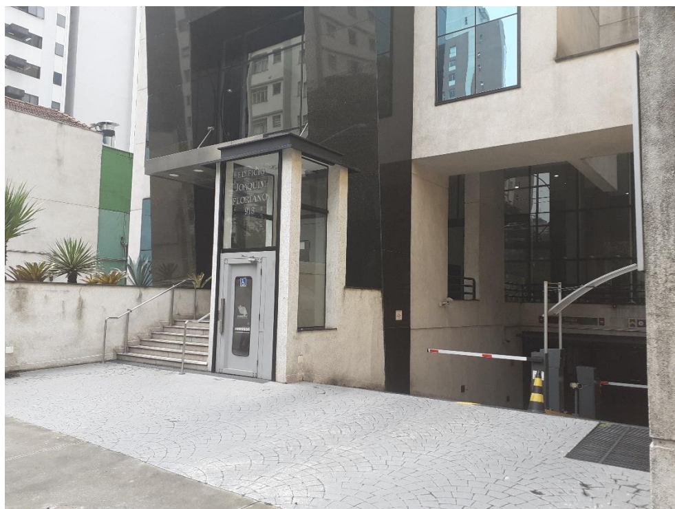
Acesso ao estacionamento do térreo pela Rua Joaquim Floriano
