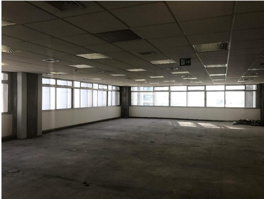
Vista interna de um andar tipo vago
