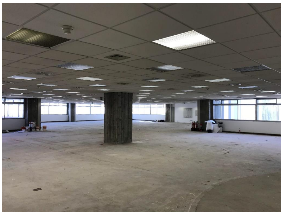
Vista interna de um andar tipo vago
